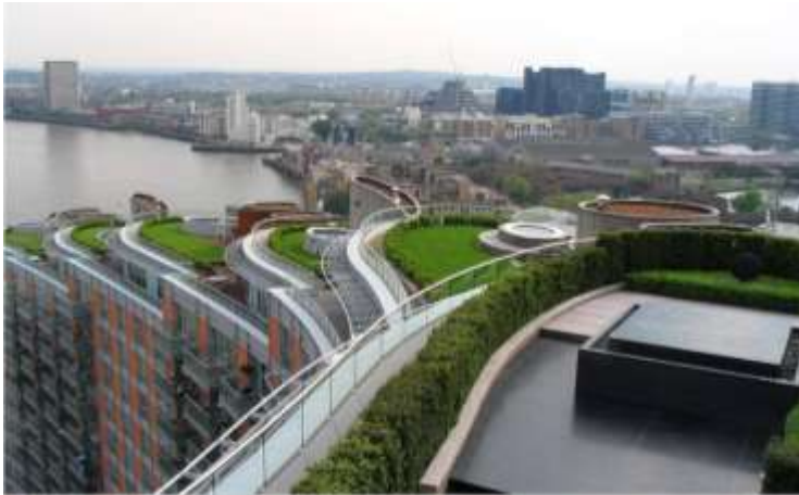
Das Projekt New Providence Wharf in London besticht durch seine kaskadenartigen Dachgärten mit Blick auf die Themse. © IGRA
