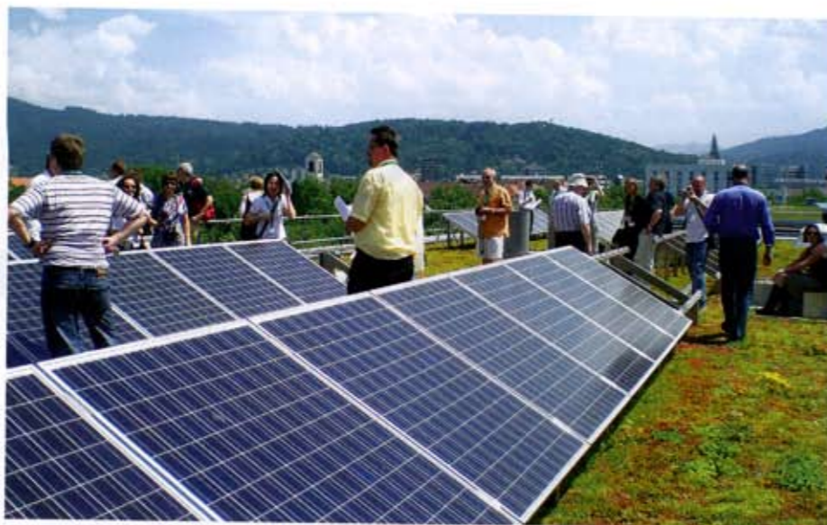
Die Referenz-Anlage auf dem Dach der Umweltmedizin in Freiburg wird regelmäßig von Besuchergruppen aus dem In- und Ausland besucht. Foto: DDV
