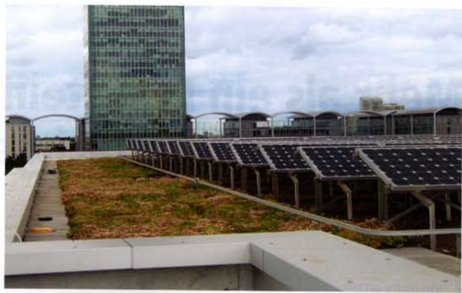
Die Kombination des schienengeführten Absturzsicherungssystems mit der Solaraufständigung ermöglicht eine komfortable Pflege- und Wartung. Foto: DDV
